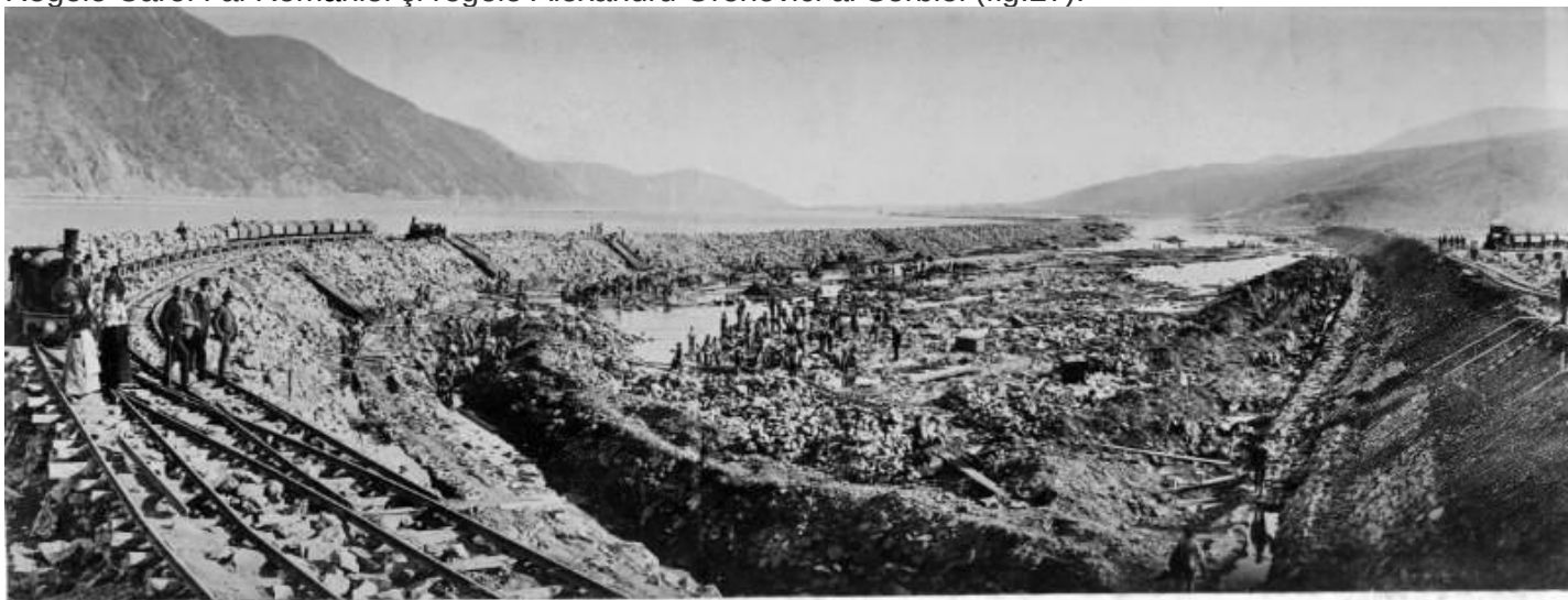
Fig.26. Lucrări de construcție la canalul Sip
