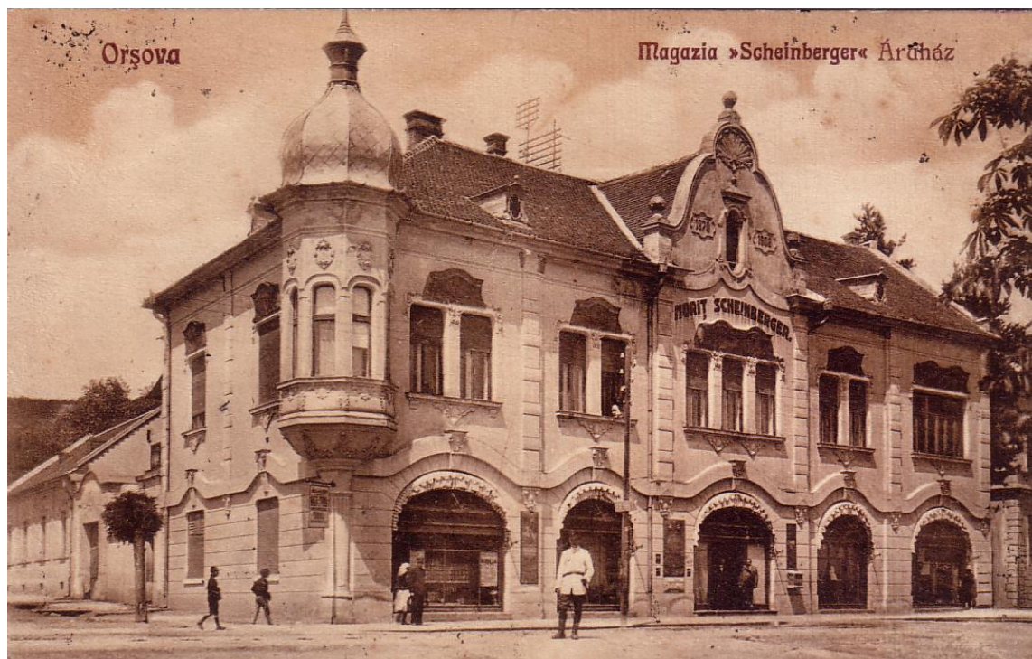
Fig. 11. Magazinul lui Mauriciu Scheinberger, reconstruit cu etaj în anul 1908-vedere dinspre piață (în această vedere Mauriciu devine Moriț, anul de fondare este 1870, deasupra clădirii se văd înălțate “etajere” pentru firele de telegraf, iar pe trotuar este pus un stâlp de telegraf ori mai degrabă de electricitate. Electrificarea Orșovei s-a făcut în 1910 conf. Gh. Manolea)
