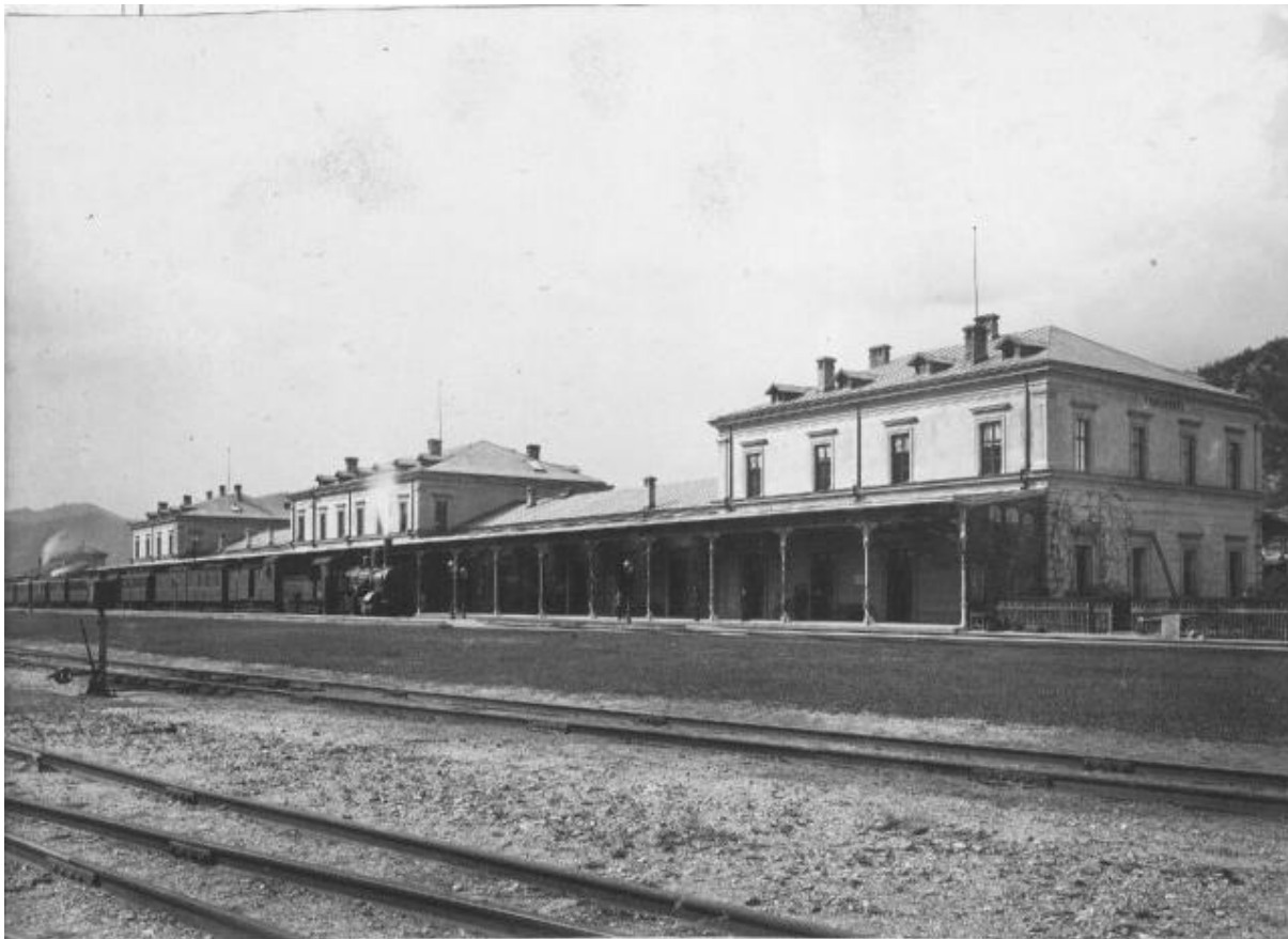
Fig.17. Gara Vârciorova-vedere dinspre Dunăre
