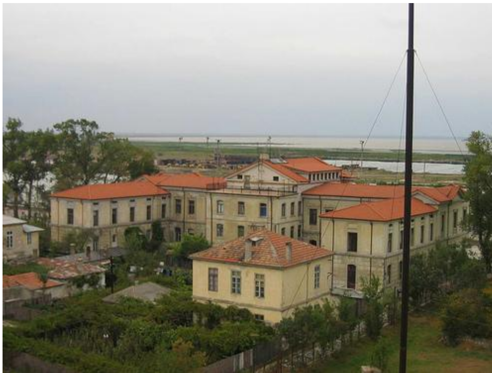
Fig. 25. Palatul CED din Sulina-vedere spre faleză
