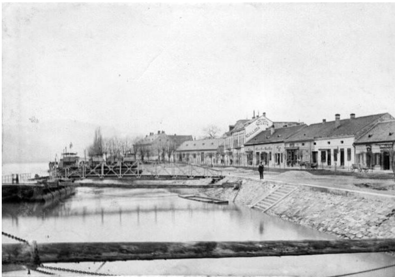
Fig.29. Taluzarea malului Dunării la faleză
