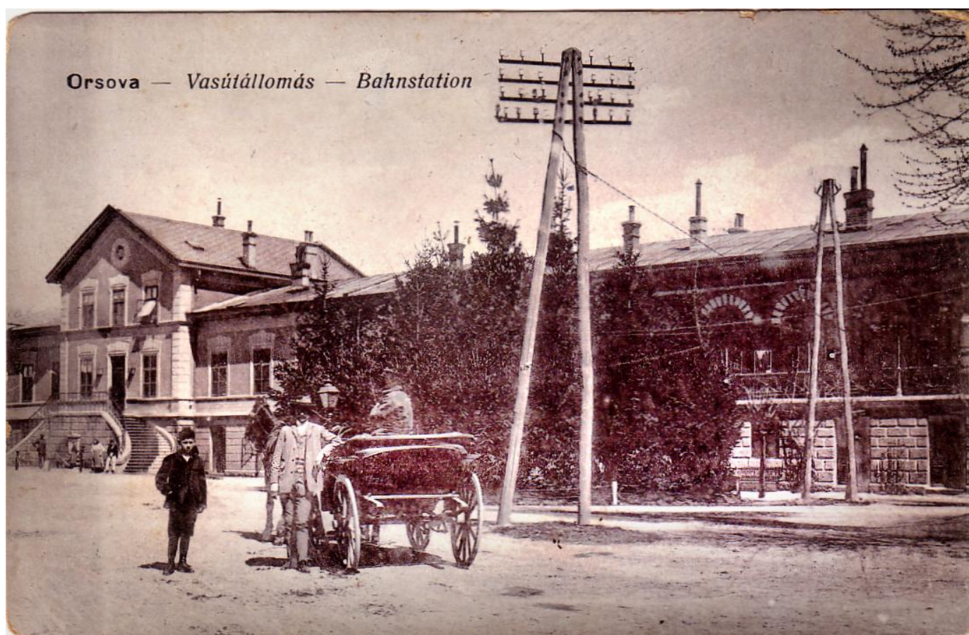
Fig.14. Gara Orșova-vedere dinspre stradă
