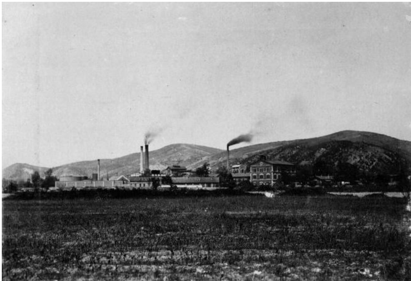
Fig.3. Rafinăria de uleiuri din Orșova-vedere dinspre Șoseaua Națională
