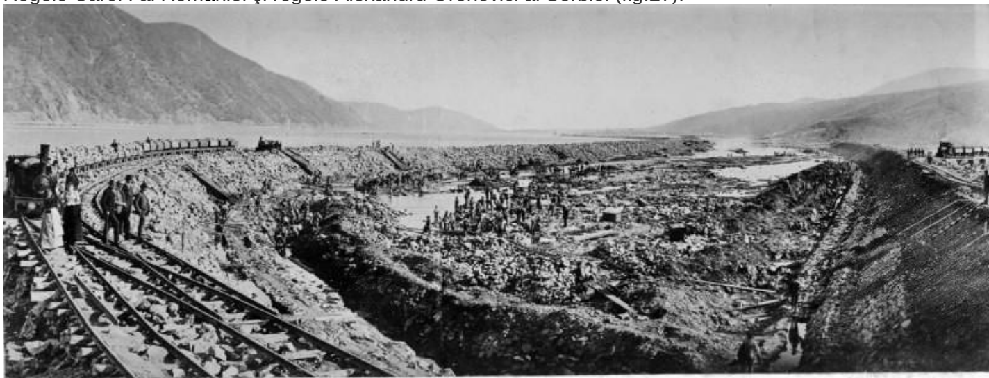
Fig.26. Lucrări de construcție la canalul Sip
