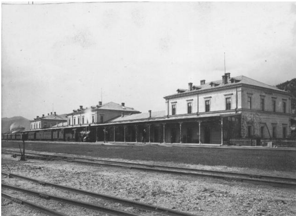
Fig.17. Gara Vârciorova-vedere dinspre Dunăre
